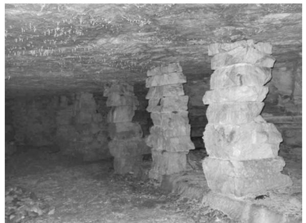
Figure 28 – Piliers à bras dans une carrière par hagues et bourrages, dans le Valois.
