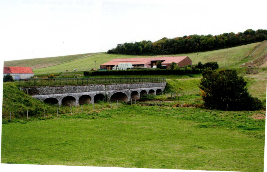
Fig. 359 : Pont-siphon de l'Aqueduc de l'Avre visible au sud de Beynes. Cliché L. Le Callonnec.
