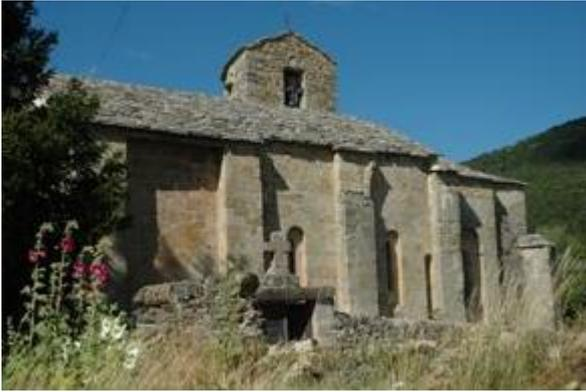
La toiture, refaite en 2006, est en lauzes calcaires
