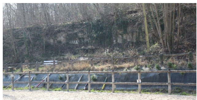
Vue d'ensemble du front de taille du Manège
